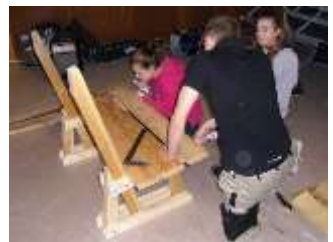
Fotos: Der neu errichtete Schuppen und der Eingang des Jugendraumes, Bilder vom Workshop mit den Jugendlichen
